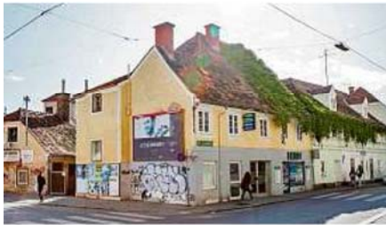
Um diese Liegenschaft ranken sich Abrissgerüchte MÖSTL
